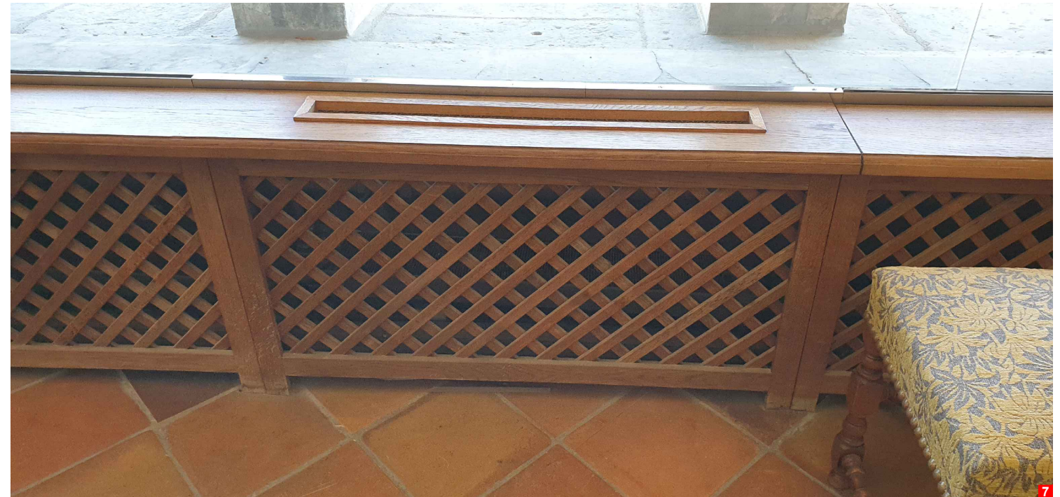
Coffre de chauffage en partie basse de l'ensemble vitré
